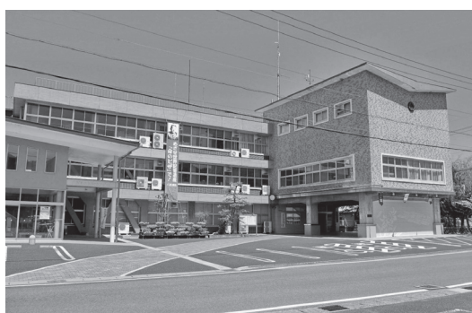
築50年以上経過した役場本庁舎
