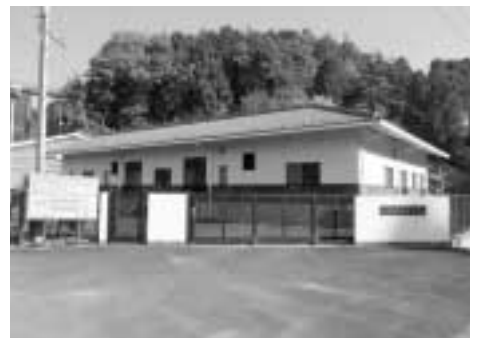
久田見浄化センター
