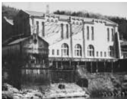
旧八百津発電所資料館
