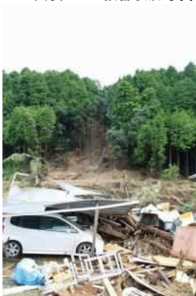
図表 21 被害状況写真（平成22(2010)年7月15日豪雨災害）
