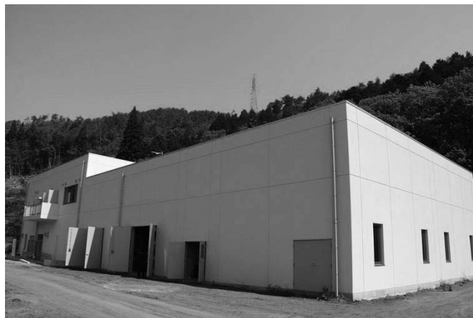
上飯田浄水場
