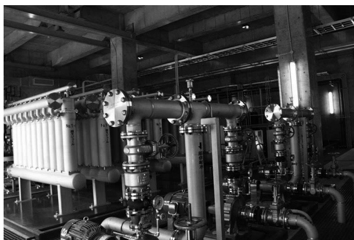
上飯田浄水場『膜ろ過機』
