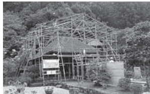
①工事中 (足場・仮屋根建設)
