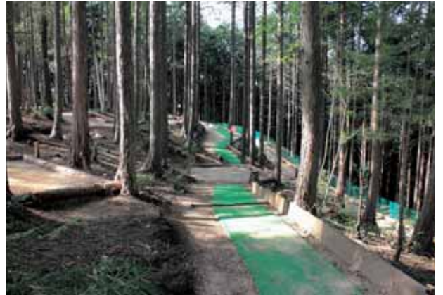
完成したマレットゴルフ場
