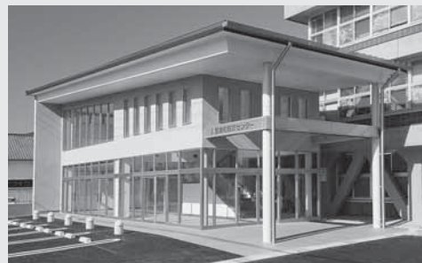
防災 センター
