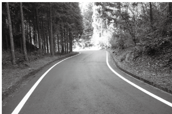
亀ヶ谷線舗装補修工事（L＝395m、A＝2,330㎡）
