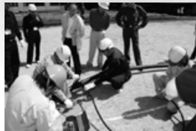
仮設水道管設置
