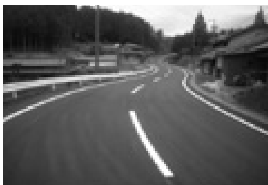
杣沢・小洞線舗装補修工事（L = 978m、A = 7,805㎡）
