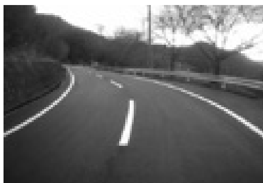
細目・北山線舗装補修工事（L = 246m、A = 2,008㎡）
