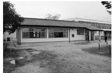
完成した和知小学校学区学童保育室
