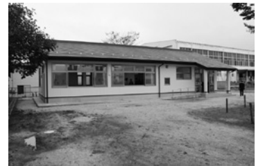
完成した和知小学校区学童保育室
