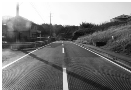
西中長・岡田線舗装補修工事(L=566m、A=3,210㎡)
