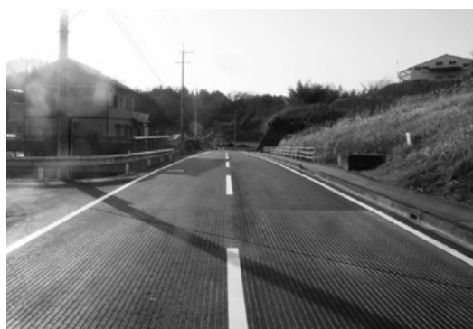
西中長・岡田線舗装補修工事(L=566m、A=3,210㎡)
