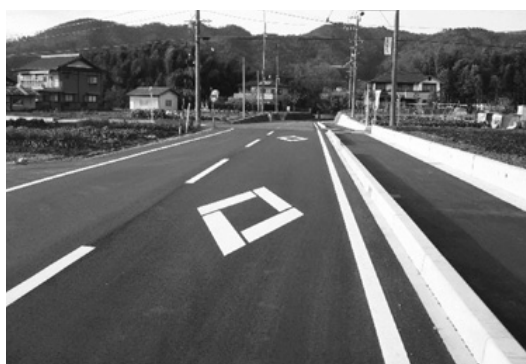
伊岐津志・野上線自歩道新設工事(L=288m、歩道幅員W=3.0m)
