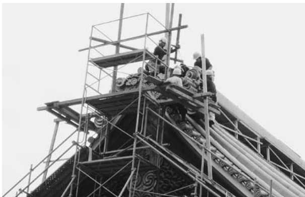
高さ18メートルもある棟での取付作業
