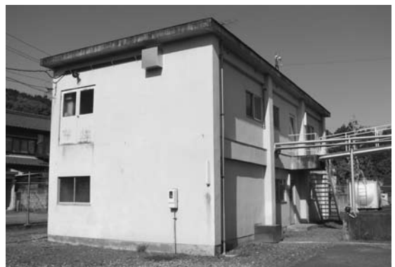
耐震化予定の須賀浄水場管理棟
