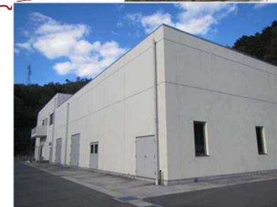
◆久田見浄水場◆
