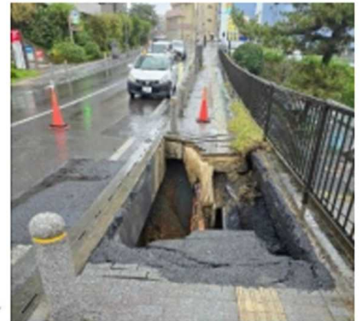
下水道の老朽化やコンクリートの腐食による陥没
