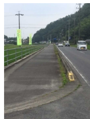
⑬ ガードパイプ設置
