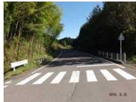
⑤横断歩道 注意看板等設置
