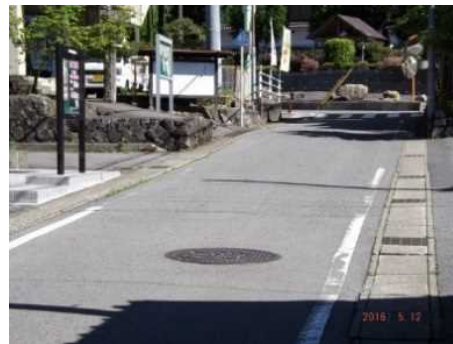
③路側帯カラー舗装
