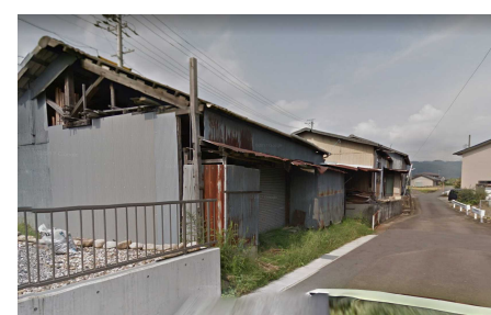
②③危険個所の撤去(写真は町道側)
