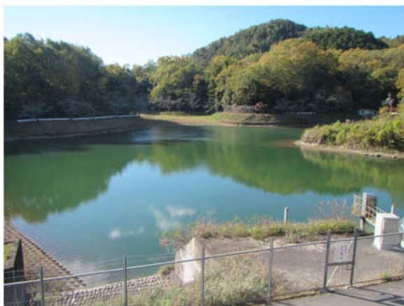
◆上飯田調整池（上飯田浄水場）◆
