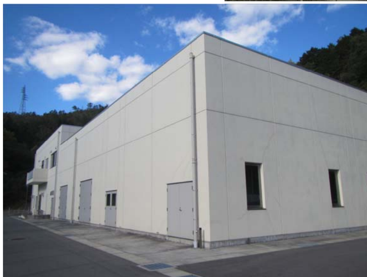
◆上飯田浄水場◆
