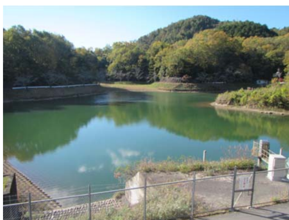
◆上飯田調整池（上飯田浄水場）◆
