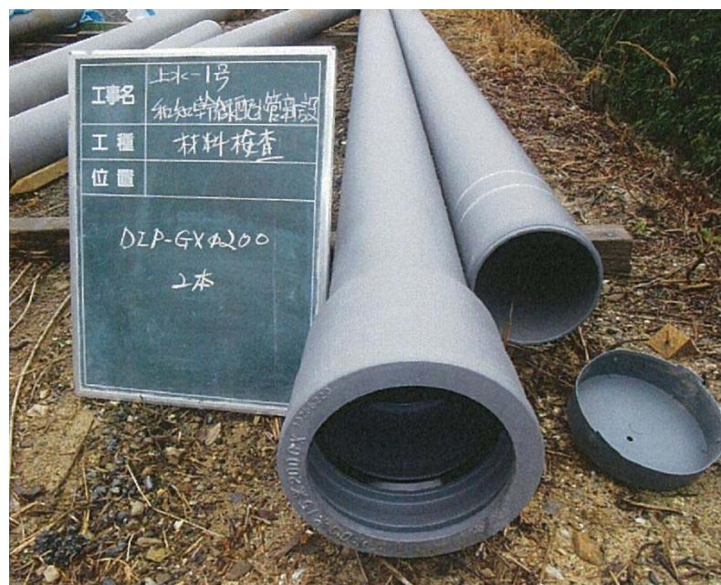
◆長寿命管 ダクタイル鉄管(GX形)◆
