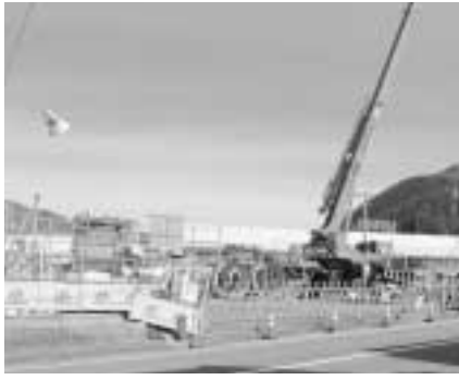
八百津排水路整備工事現場
