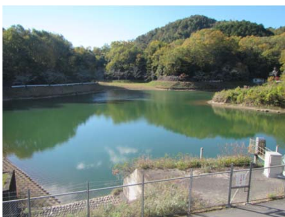
◆上飯田調整池（上飯田浄水場）◆
