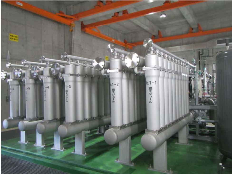
◆上飯田浄水場 膜ろ過装置◆
