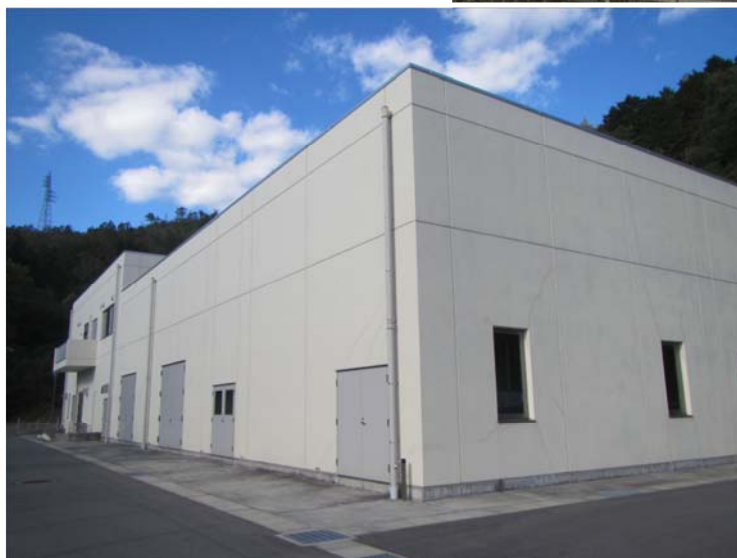
◆上飯田浄水場◆
