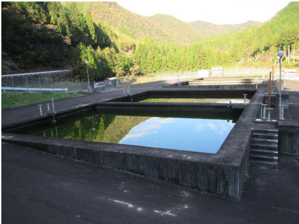
◆木野浄水場 緩速ろ過池◆
