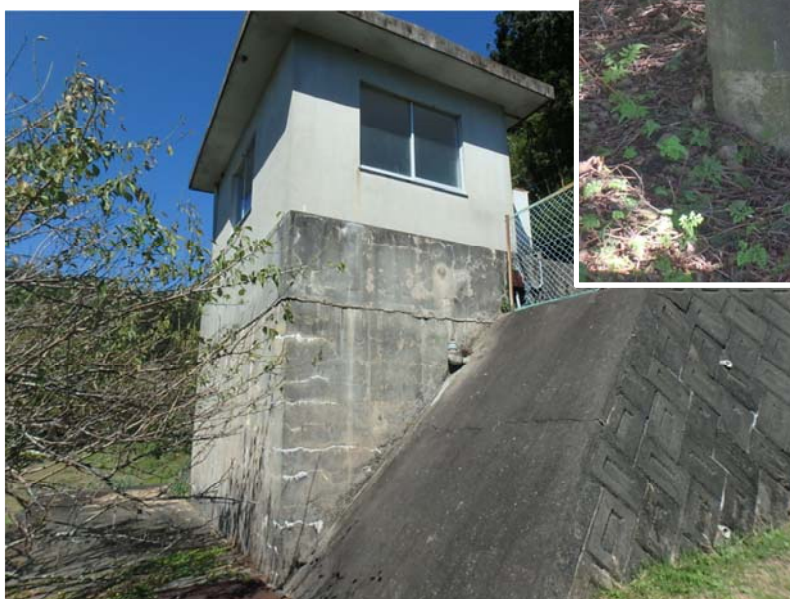
◆北山低区配水池◆
