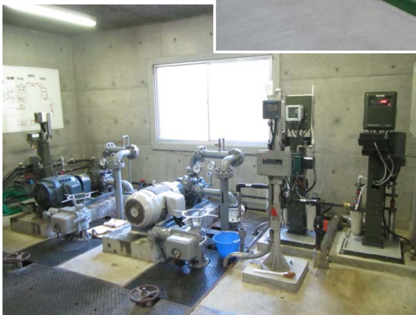
◆久田見浄水場 水質監視設備◆
