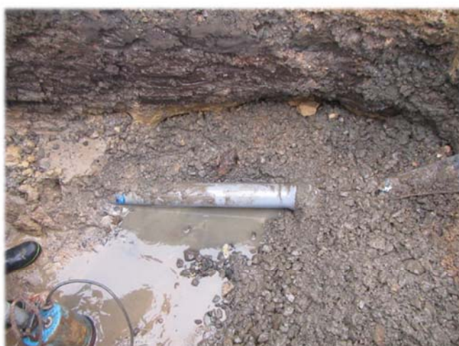
◆管路漏水被害◆
