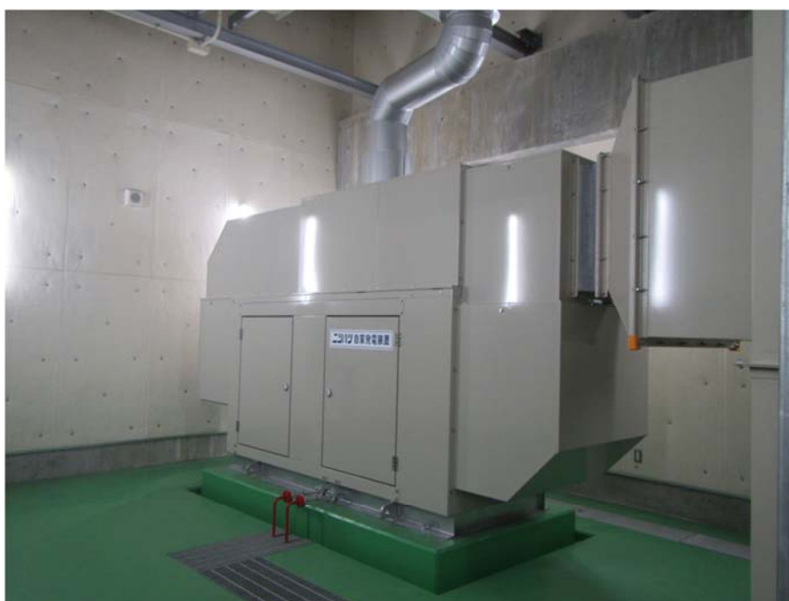
◆上飯田浄水場 自家発電設備◆
