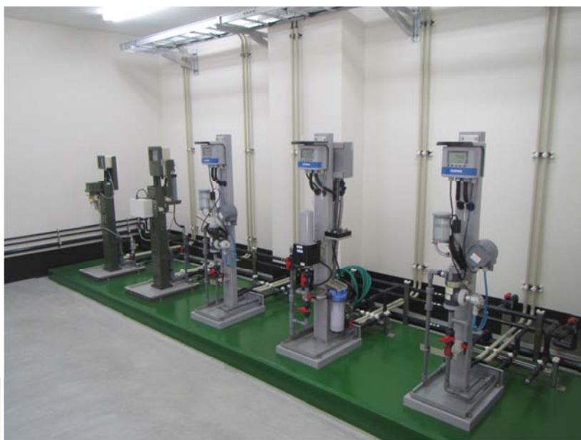
◆上飯田浄水場 水質監視設備◆
