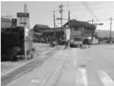
国道418号水道工事現場
